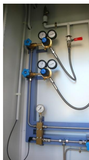
Salidas de aire medicinal y oxígeno a red hospitalaria
